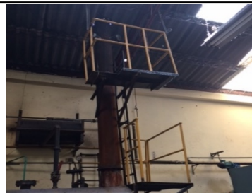
FOTOGRAFÍA 4: DUCTO CALDERA (PLATAFORMA DE ACCESO)
