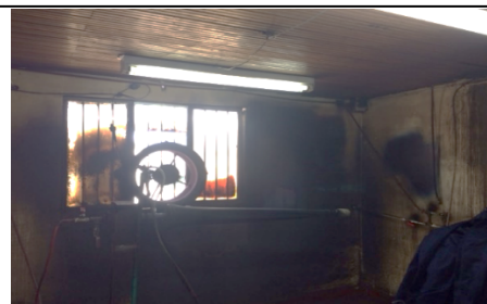
FOTOGRAFÍA 6: CUARTO DE SANDBLASTING
